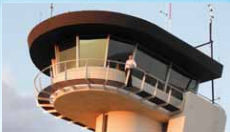
THALES Tour de contrôle de Namibie ©Dominique BOULAY/THALES
